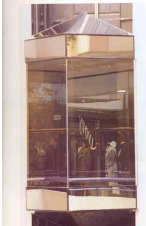
Εξωτερικός ανελκυστήρας σε γυάλινο φρεάτιο
