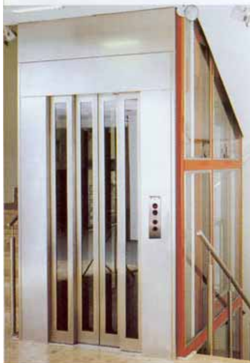
Ανελκυστήρας ατόμων σε ένα εξωτερικό πανοραμικό φρεσίνιο, με αυτόματες πόρτες σε πολυκατάστημα
