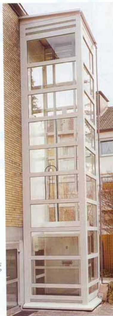
Εξωτερικός ανελκυστήρας σε γυάλινο φρεάτιο
