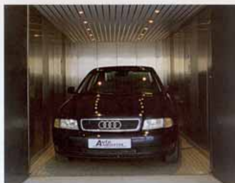
Αυτόματος ανελκυστήρας αυτοκινήτων parking garage
